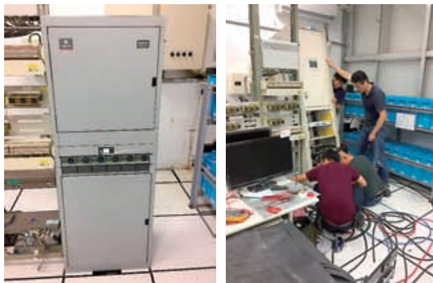
汰換萬盛微波臺交換式直流充電機
